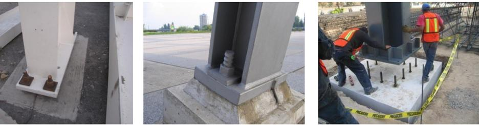
Le comportement mécanique global des assemblages des pieds des poteaux et mâts en acier, est le thème de la thèse de doctorat en construction métallique. Elle consiste à définir les typologies structurales des pieds de poteaux, colonnes et mâts en acier et à étudier leurs modes de stabilité statique, dynamique et de fatigue. Comprendre correctement leur comportement aidera le concepteur à mieux dimensionner son élément.
